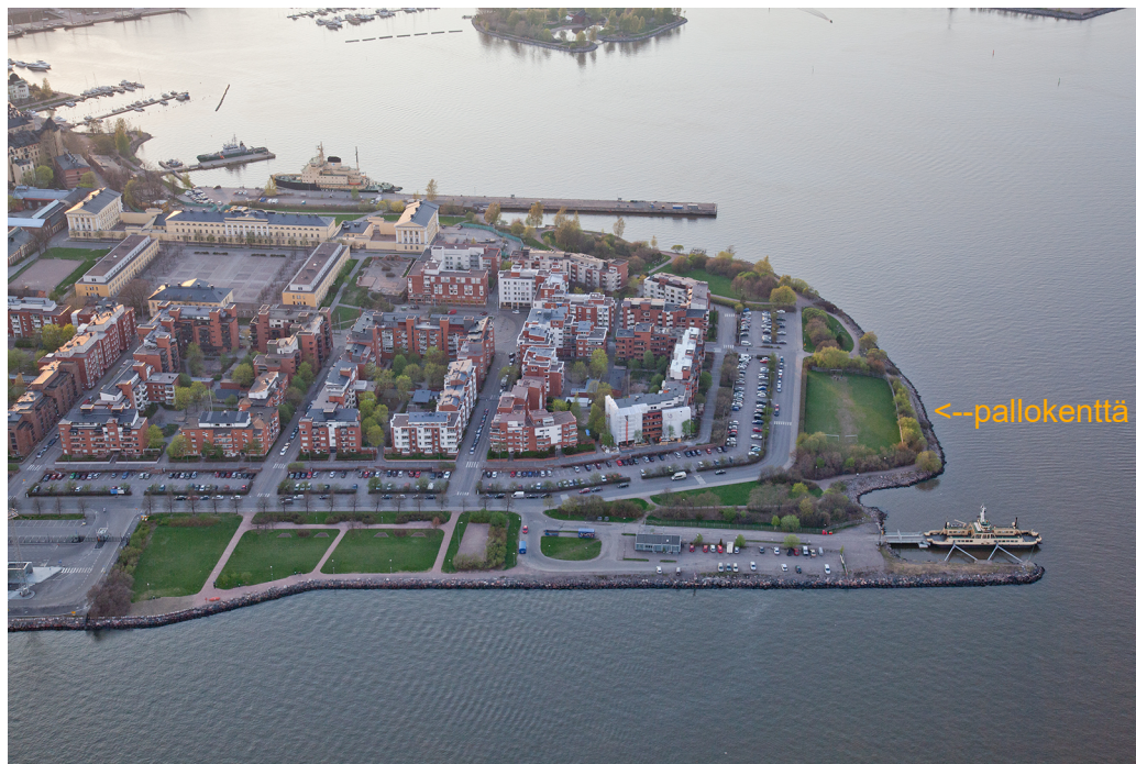
Katajanokan kärki, pallokentän huono kunto näkyy selvästi.
